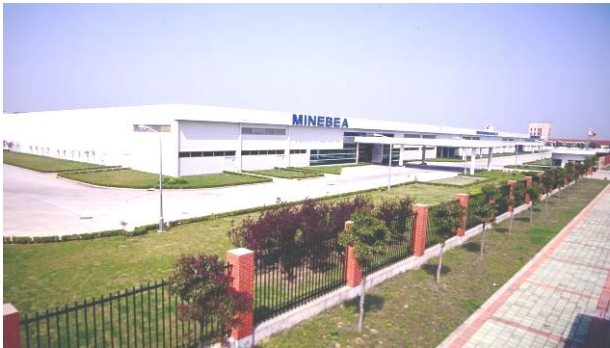
西岑工场外景
